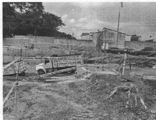
VISTA INTERNA DEL INMUEBLE
