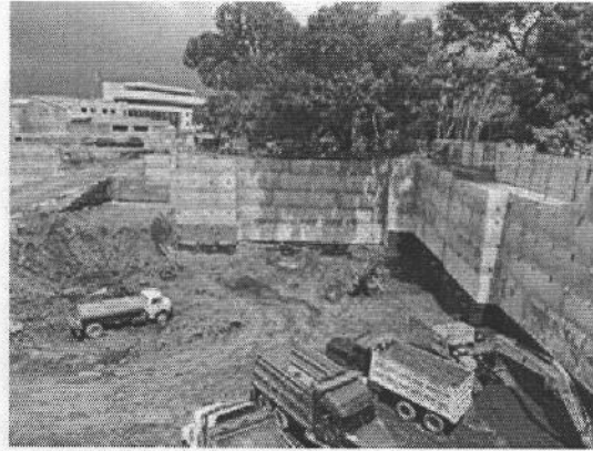
VISTA INTERNA DEL INMUEBLE
