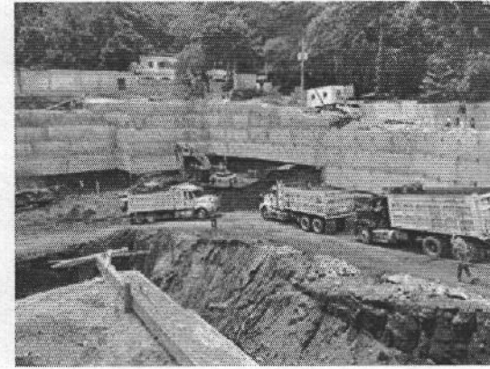
VISTA INTERNA DEL INMUEBLE
