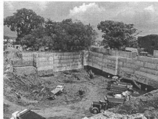
VISTA INTERNA DEL INMUEBLE
