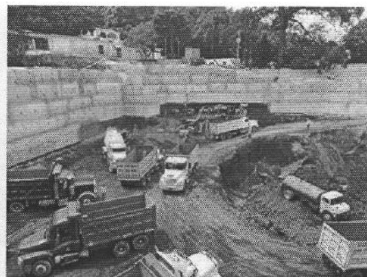
VISTA INTERNA DEL INMUEBLE
