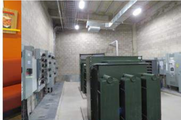
VISTA AREAS DE APOYO
