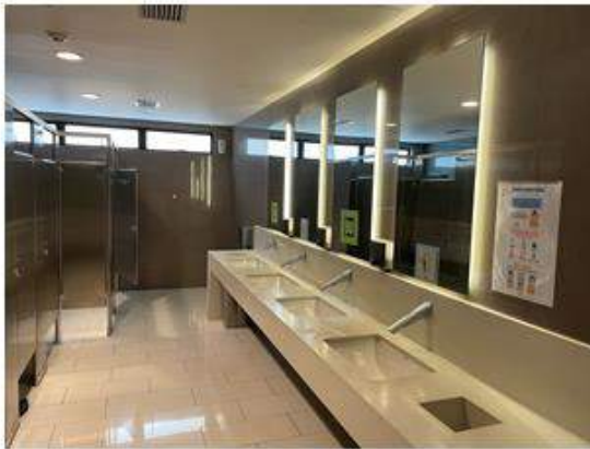
VISTA DE BAÑOS
