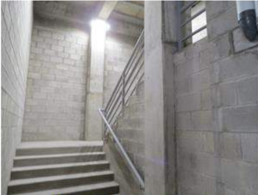
VISTA AREAS DE APOYO
