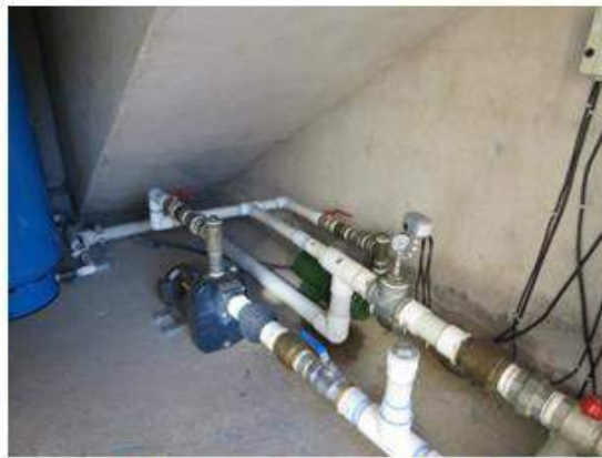
VISTA AREA DE APOYO
