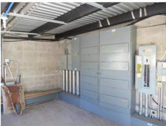
VISTA AREA DE APOYO
