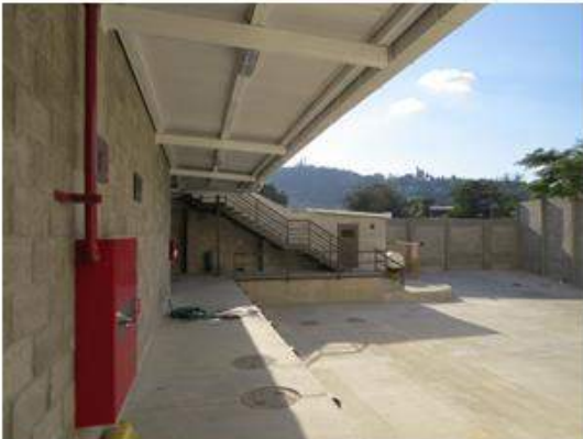
VISTA AREAS DE APOYO
