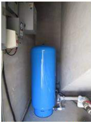
VISTA AREA DE APOYO
