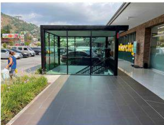
VISTA PASILLO DE ACCESO
