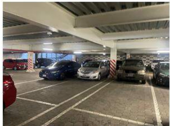
VISTA DE ESTACIONAMIENTO
