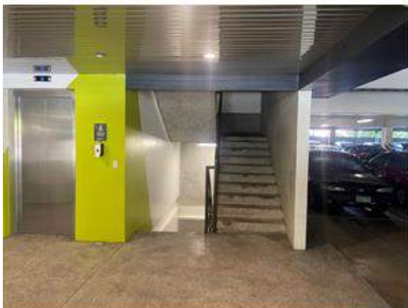
VISTA DE GRADAS INTERNAS
