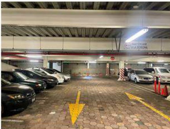
VISTA DE PRIMER NIVEL
