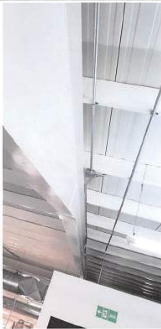
Estructuras de Techo
