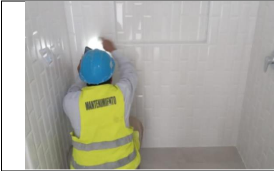
Fotografía 1. Instalación de muebles fijos.
