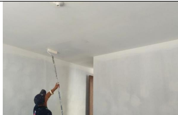
Fotografía 2. Aplicación de Pintura.
