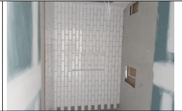
Fotografía 2. Enchapes en área de duchas.
