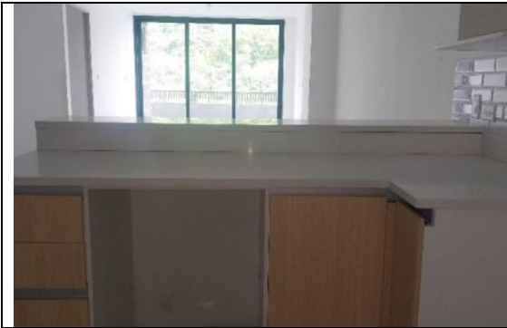
Fotografía 1. Instalación de muebles fijos.
