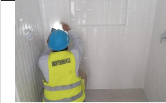
Fotografía 1. Instalación de muebles fijos.
