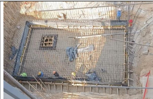
Fotografía 1. Armado, moldeado y colado de losa de cisterna.
