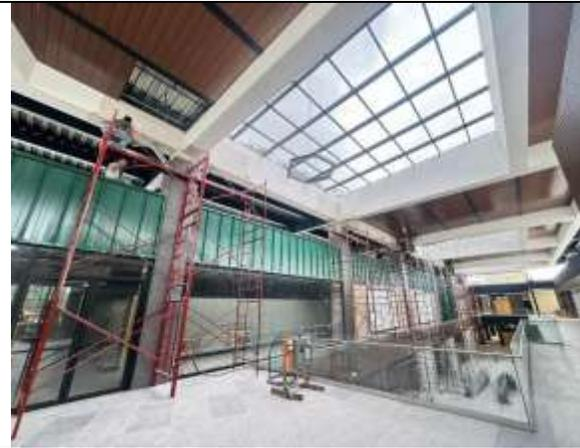
**Fotografía 8.** Montaje de duela de aluminio tipo madera
