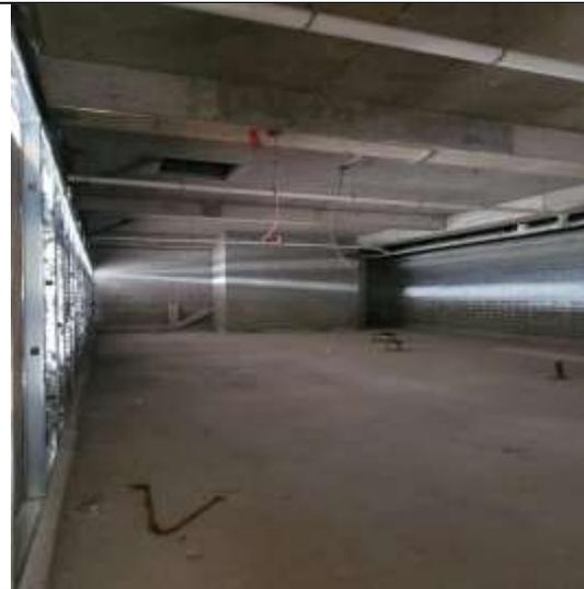
**Fotografía 4.** Instalación de sistema de tubería contra incendio
