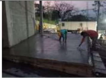
**Fotografía 10.** Colado de losa para tanque
