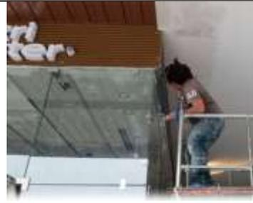
**Fotografía 8.** Aplicación de pintura en fascia de fachada de locales
