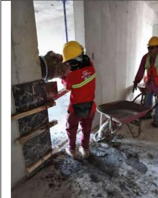
**Fotografía 1.** Vaciado de concreto reañizado desde nivel 2
