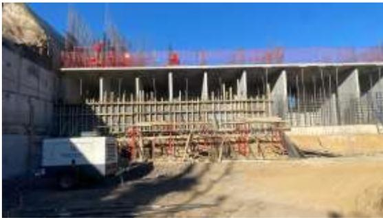
**Fotografía 3.** Moldeado de paredes de cisterna eje A
