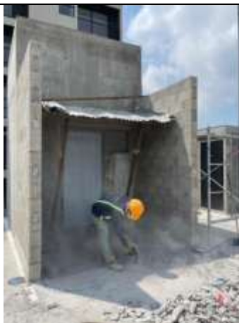
Fotografía 5. Contrapiso en salida de elevador estacionamiento
