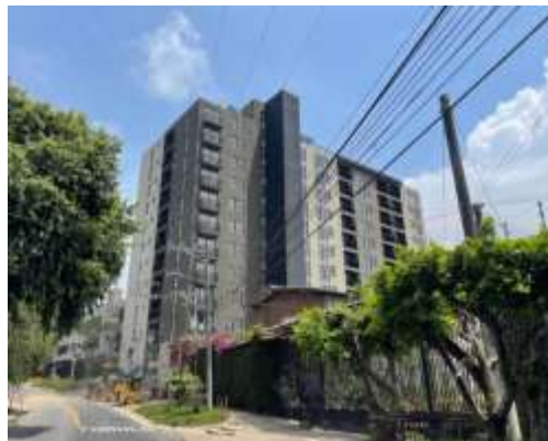
Fotografía 6. Fachada nor oriente
