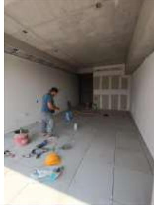
**Fotografía 8.** Instalación de cerámica en pisos
