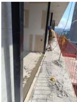
Fotografía 7. Línea y nivelación de terraza
