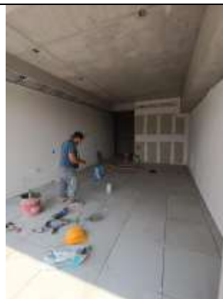
Fotografía 8. Instalación de cerámica en pisos
