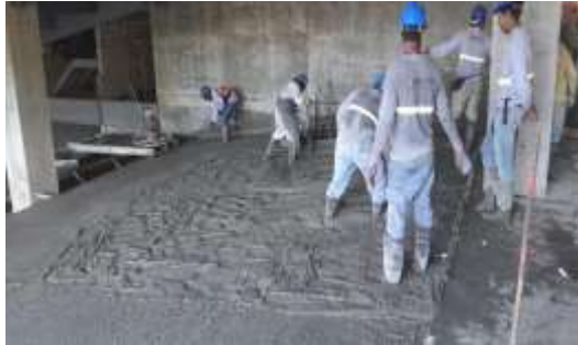
Fotografía 1. Finalización de colado de losa de cisterna en Nivel 1
