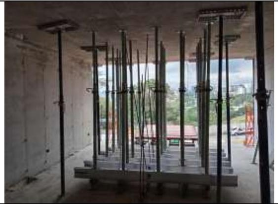
**Fotografía 6.** Montaje de plataformas de carga
