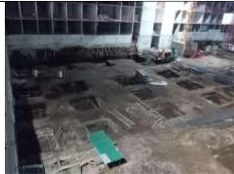
**Fotografía 2.** Armado de zapatas y pedestales
