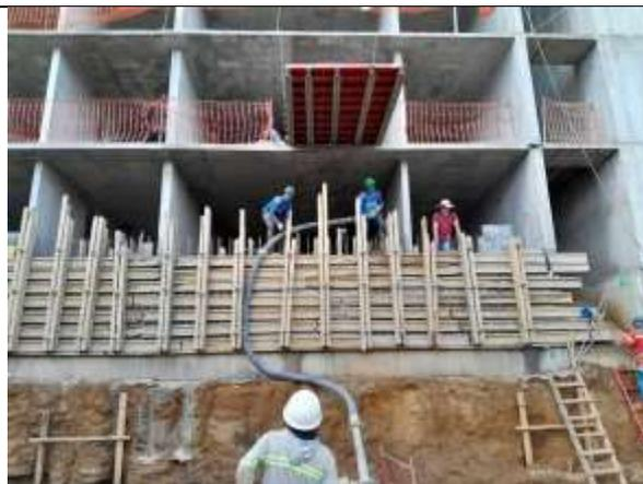
**Fotografía 3.** Colado de muro PC-25 eje A entre ejes 3' y 7'
