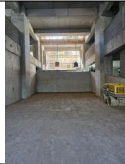
Fotografía 4. Compactación de relleno en sótano
