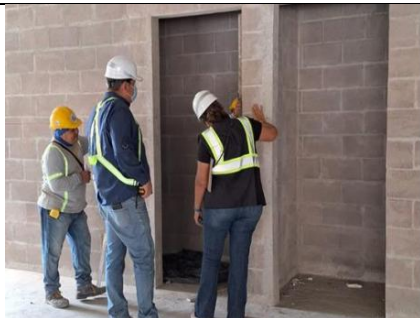
Fotografía 7. Recepción de paredes de bloque
