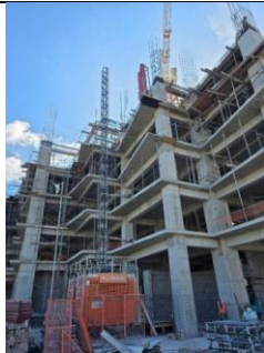
Fotografía 5. Avance en altura de estructura de torre
