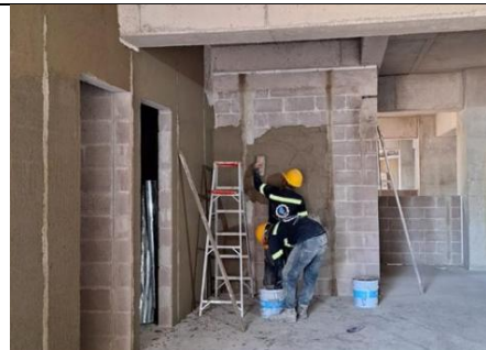
Fotografía 8. Repello de paredes en sótano medio
