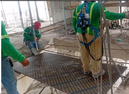
Fotografía 3. Instalación de protección de vanos.
