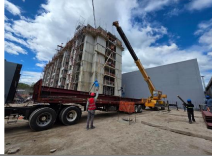
Fotografía 8. Descarga de estructura metálica para edificio de estacionamientos.
