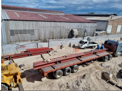
Fotografía 7. Llegada desde plantel de Construmet, de columnas y vigas metálicas para Parqueos.
