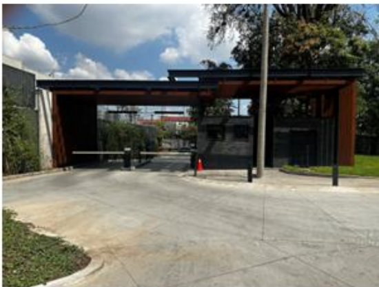
VISTA INTERNA DEL INMUEBLE
