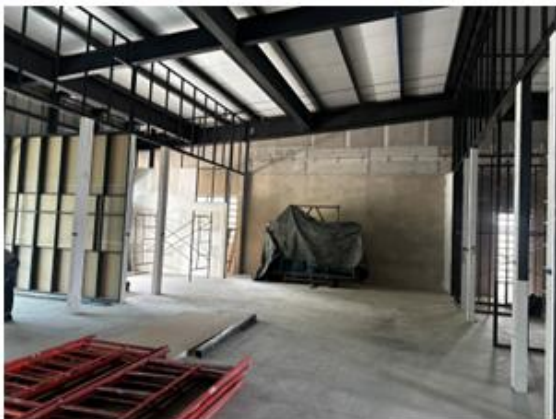
VISTA DE EQUIPOS
