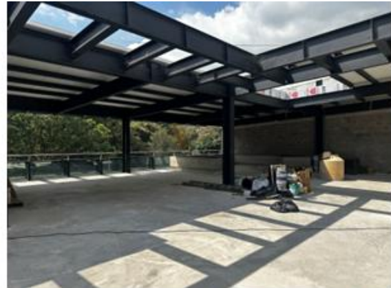
VISTA INTERNA DEL INMUEBLE
