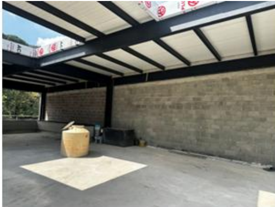
VISTA INTERNA DEL INMUEBLE
