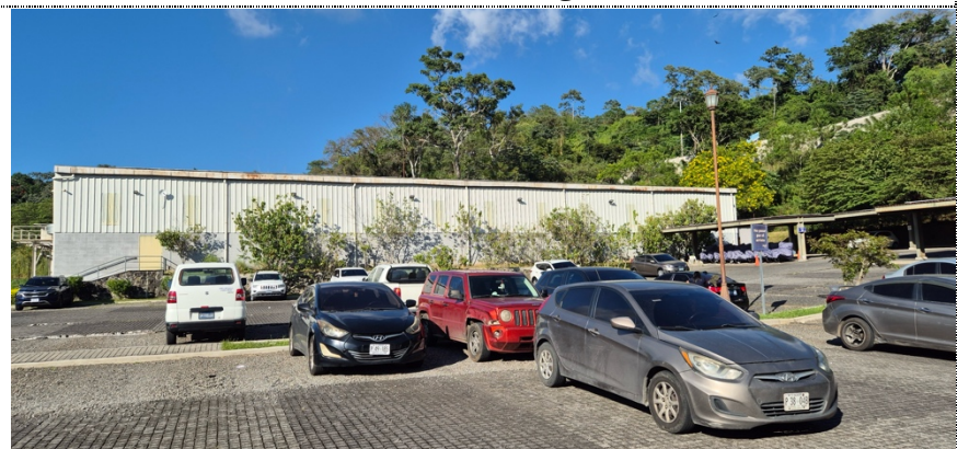
Bodega Fachada Sur
