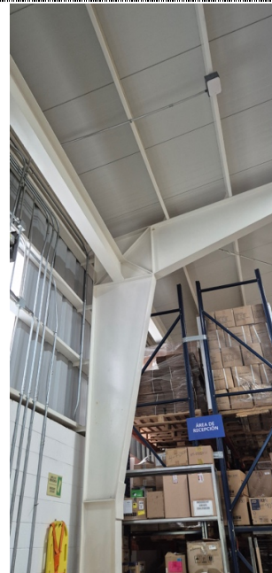
Estructuras de Techo
