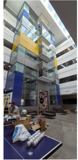
Fachada de Ascensores
