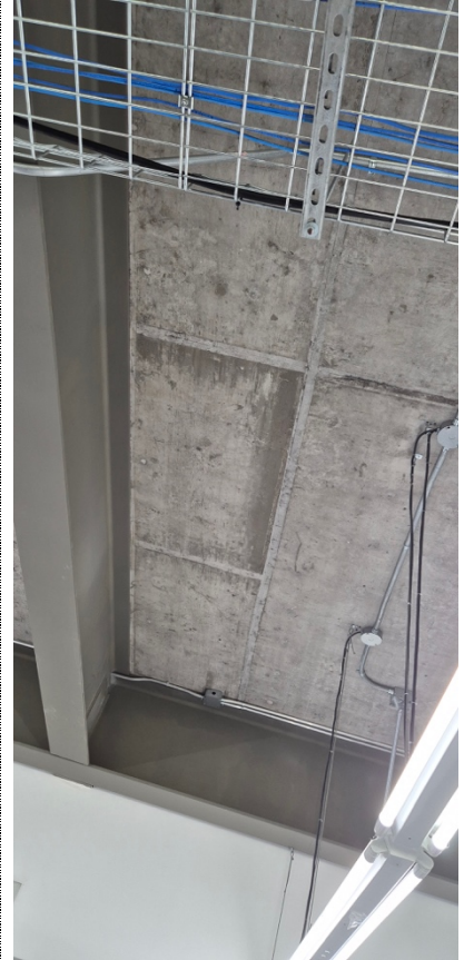
Vista Inferior Losa Nivel 5 Sin daños
