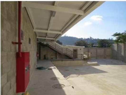
VISTA AREAS DE APOYO
