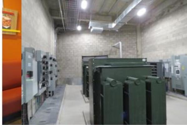
VISTA AREAS DE APOYO
