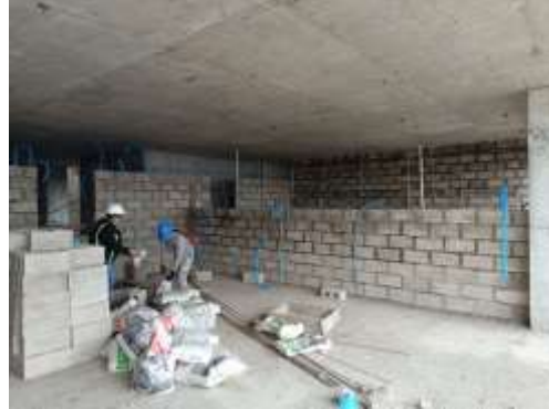
Fotografía 8. Pegado de bloques de apartamentos N17
