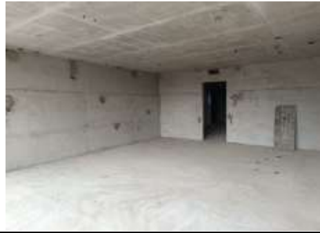
Fotografía 6. Repellado y afinado de paredes N14
