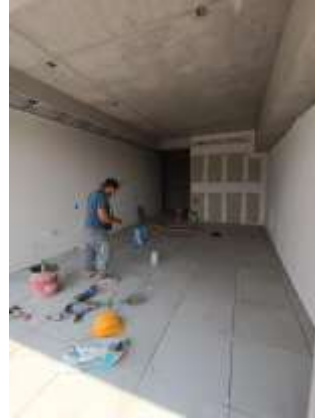
Fotografía 8. Instalación de cerámica en pisos
