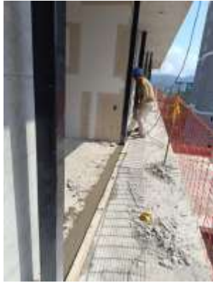
Fotografía 7. Línea y nivelación de terraza
