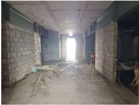
Fotografía 7. Pegado de bloques N16
