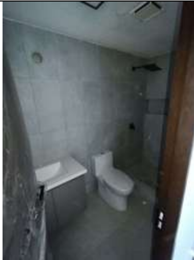
Fotografía 9. Instalación servicios sanitarios en torre
