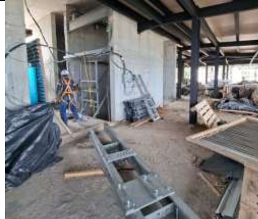
Fotografía 8. Avance Obra Civil Elevador 1
