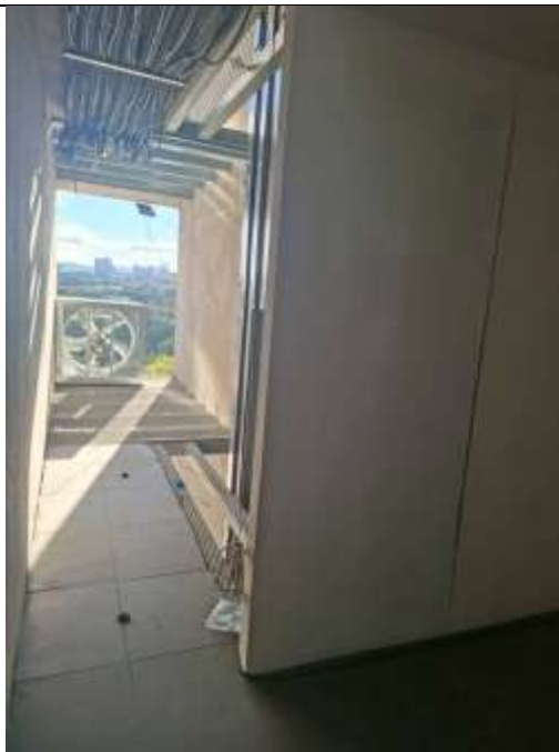
Fotografía 9. Instalación sistemas de ventilación y aires acondicionados
