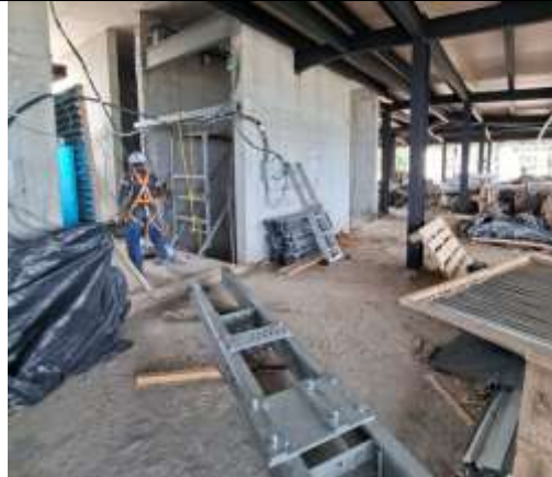
Fotografía 8. Avance Obra Civil Elevador 1
