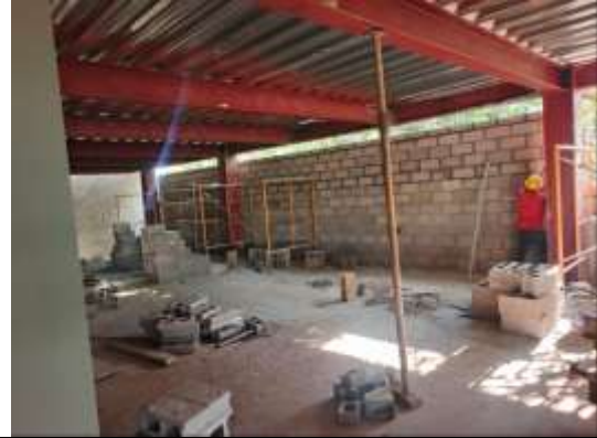
Fotografía 4. Avance Muro en Estacionamiento
