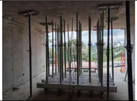
Fotografía 6. Montaje de plataformas de carga
