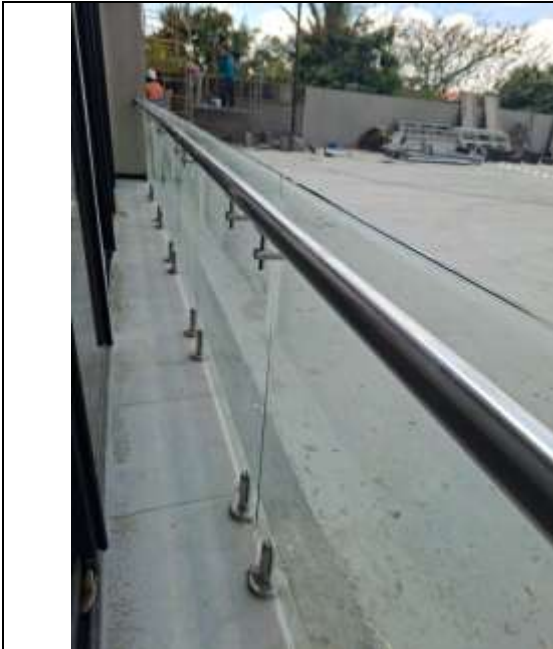
Fotografía 7. Instalación vidriería
