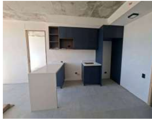
Fotografía 10. Instalación muebles en torre
