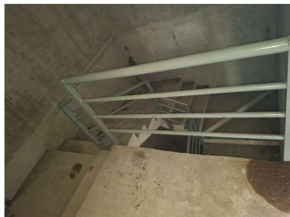
Fotografía 2. Escaleras y Pasamanos del edificio
