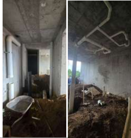
Fotografía 4. Compactación con lodocreto en nivel 1
