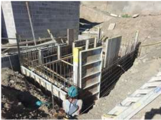
Fotografía 5. Avance Casa Club
