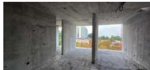
Fotografía 8. Instalaciones de Paredes en nivel 7
