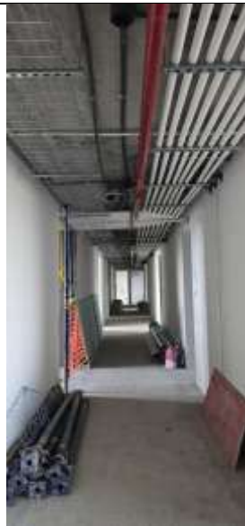
Fotografía 5. Avances en estructura hidráulica
