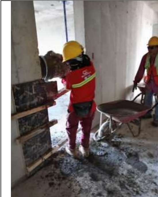
Fotografía 1. Vaciado de concreto reañizado desde nivel 2
