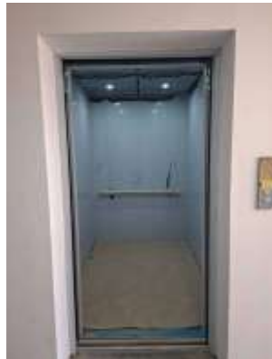
Fotografía 7. Avance Obra Civil Elevador 1
