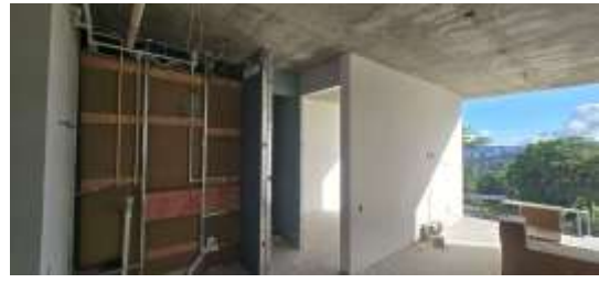
Fotografía 8. Instalaciones de Paredes en nivel 9
