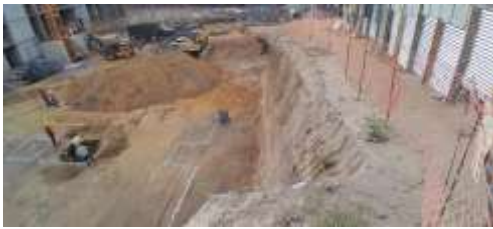
Fotografía 7. Trazo y excavaciones en área de edificio de estacionamiento
