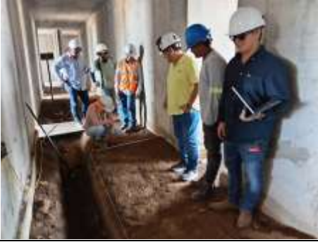
Fotografía 5. Trabajos en infraestructura enterrada primer nivel
