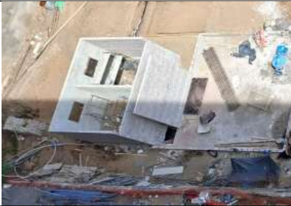
Fotografía 5. Avance Casa Club
