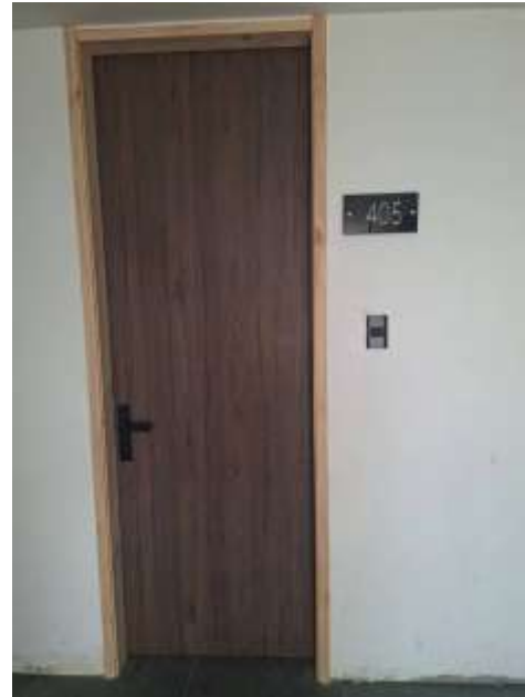
Fotografía 8. Afinado de detalles (Colocación de números en apartamentos)
