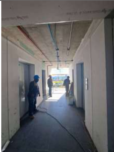
Fotografía 11. Instalación cielo falso
