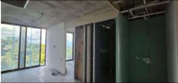
Fotografía 5. Avances en estructura hidráulica
