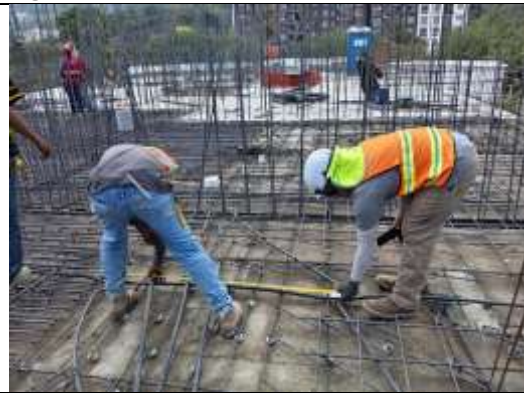
Fotografía 8. Instalaciones hidráulicas y eléctricas
