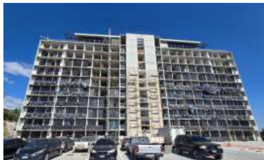
Fotografía 1. Fachada Norte Torre
