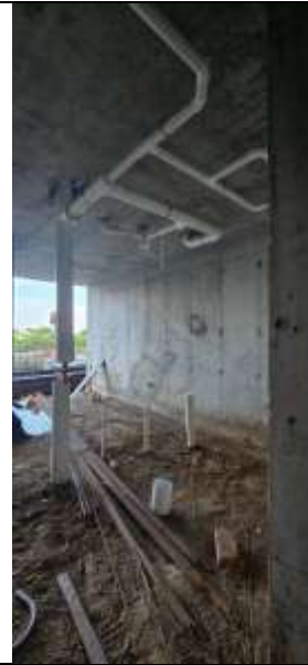
Fotografía 4. Compactación con lodocreto en nivel 1
