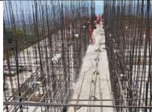
Fotografía 8. Instalaciones hidráulicas y eléctricas
