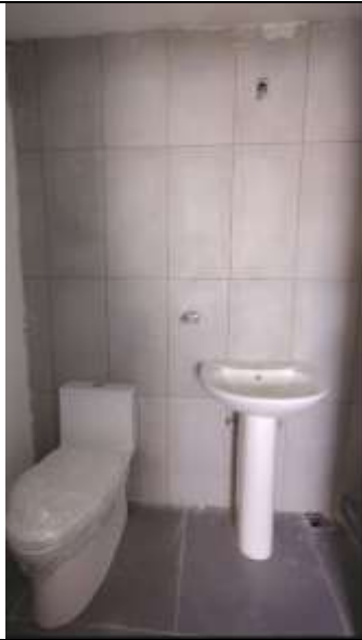
Fotografía 9. Instalación servicios sanitarios en torre
