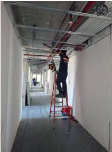
Fotografía 11. Instalación cielo falso
