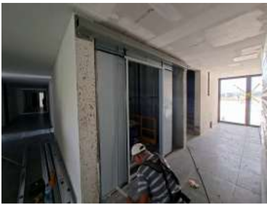
Fotografía 7. Avance Obra Civil Elevador 1
