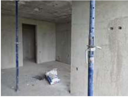
Fotografía 5. Repello primera capa al interior de apartamentos
