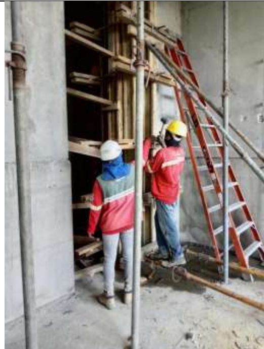
Fotografía 2. Colado de reparación en elementos de borde de muros 10ª y 9ª
