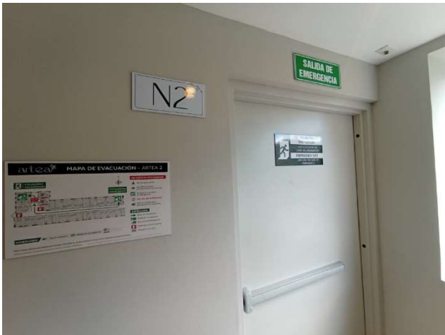
SALIDA DE EMERGENCIA COMUN NIVEL 2 AL NIVEL 11
