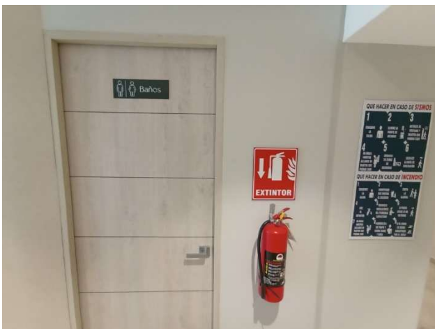
BAÑO COMUN NIVEL 2 AL NIVEL 11
