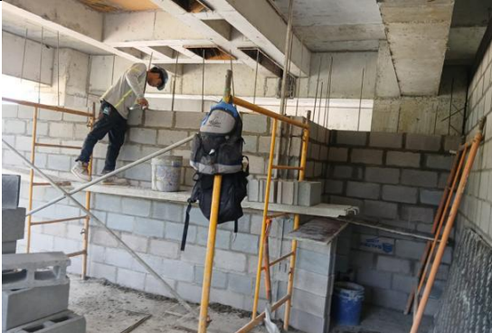
Fotografía 3. Avance paredes en nivel 18
