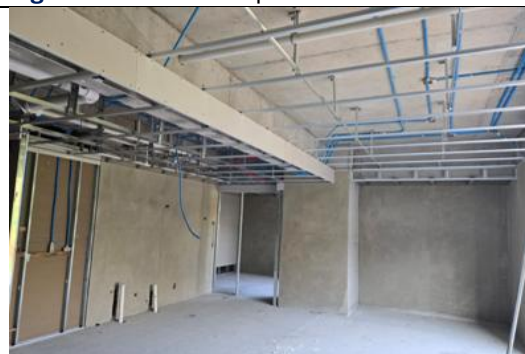
Fotografía 12. Estructura de cielo falso nivel 3
