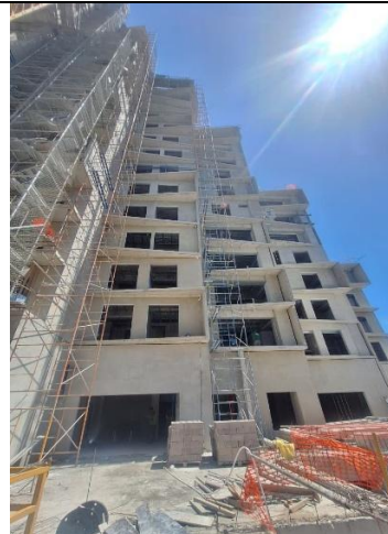
Fotografía 8. Repello en fachada sur.
