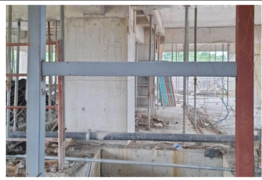
Fotografía 4. Estructura metálica elevadores Nivel 18.
