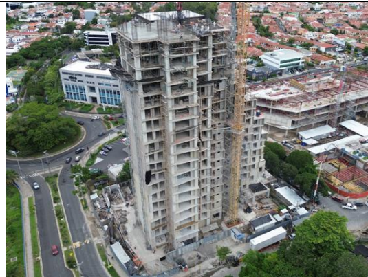
Fotografía 2. Avance paredes en fachadas.
