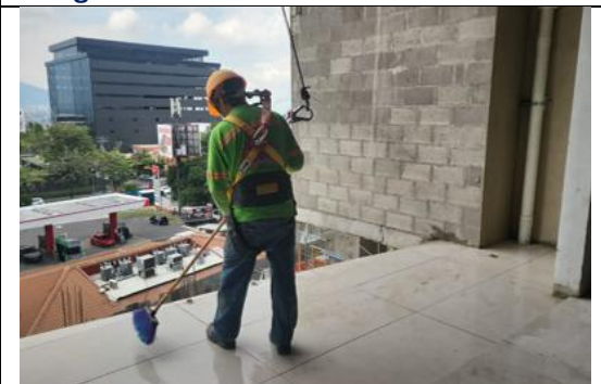
Fotografía 9. Piso en terraza de nivel 2
