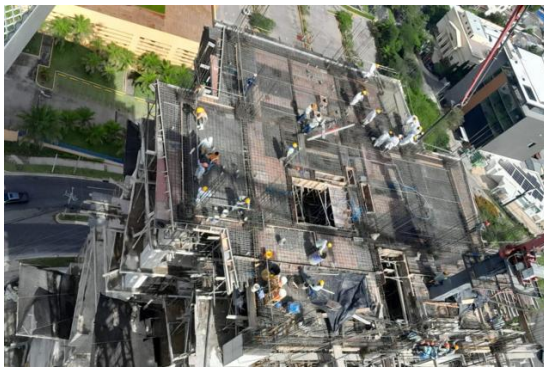
Fotografía 1. Colado tramo 1, losa 23 (nivel 22)
