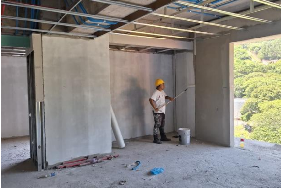
Fotografía 5. Aplicación de base para pintura Nivel 8.
