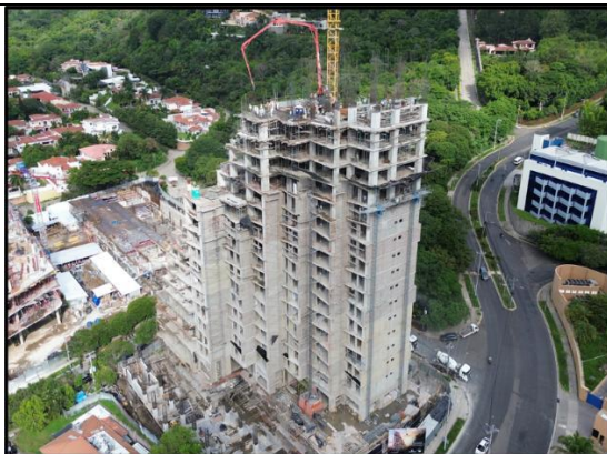
Fotografía 5. Colado losa 20, tramo 2 (nivel 19)
