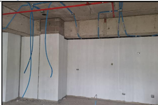
Fotografía 12. Aplicación de base para pintura
