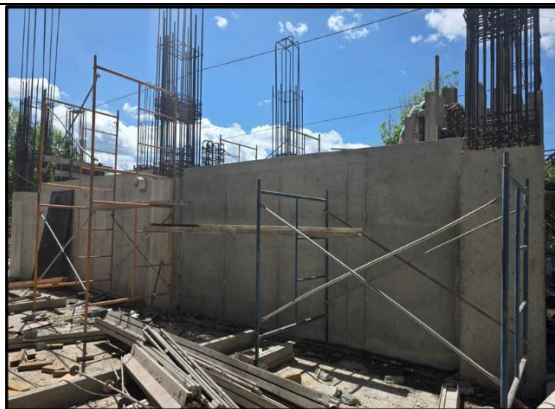
Fotografía 6. Cisterna de laminación (oriente)
