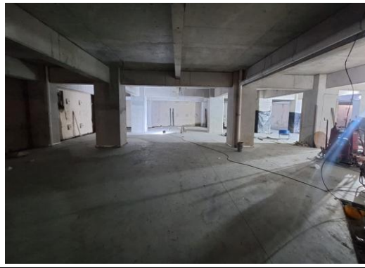
Fotografía 6. Pavimento colado en sótano inferior.
