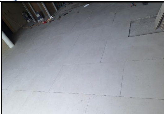
Fotografía 9. Enchape de piso nivel 2
