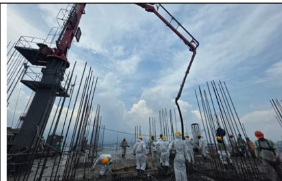
Fotografía 5. Colado de losa 18, tramo 2 (nivel 17)
