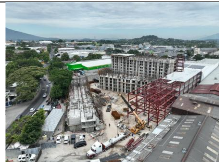
Fotografía 4. Avance de montaje de estructura de edificio de parqueos hasta eje 12.
