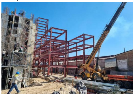
Fotografía 9. Montaje de estructura metálica de edificio de Parqueos.
