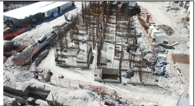
Fotografía 2. Compactación sobre losa de fundación h=1.20 m en Torre B.
