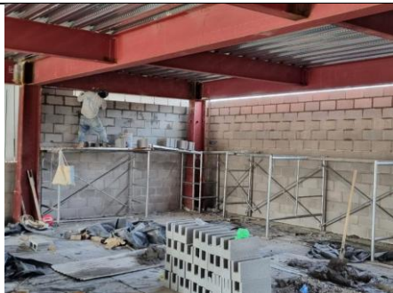
Fotografía 9. Construcción de paredes de mampostería en edificio de Parqueos.
