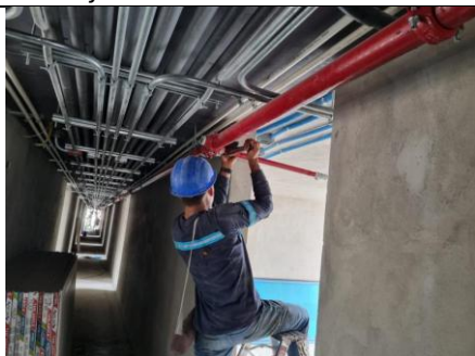
Fotografía 9. Avance en instalación de tubería contra incendios en Nivel 5 de Torre C.
