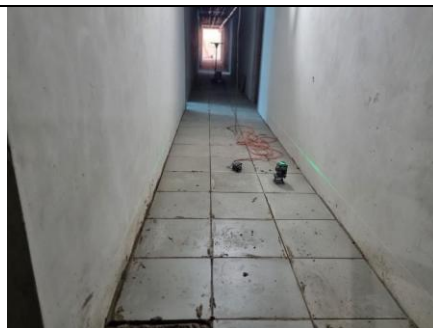
Fotografía 8. Instalación de piso cerámico en pasillos de Torre C.
