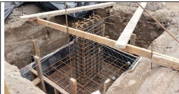
Fotografía 7. Armado y moldeado de zapatas de edificio de Amenidades.
