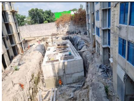
Fotografía 8. Impermeabilización de paredes exteriores de cisterna
