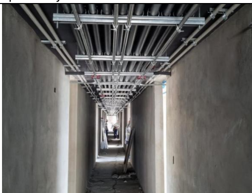
Fotografía 7. Avance en instalación de canalización de sistemas en Torre C.
