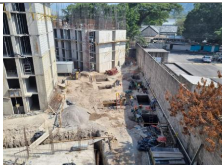
Fotografía 9. Avance en excavaciones para fundaciones de Amenidades.
