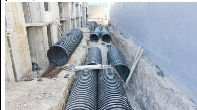
Fotografía 5. Instalación de tuberías de 60" de sistema de detención de aguas lluvias.
