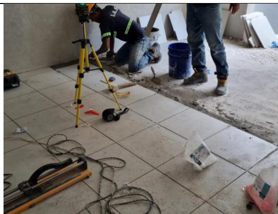
Fotografía 9. Instalación de pisos y enchapes en proceso en Torre C.
