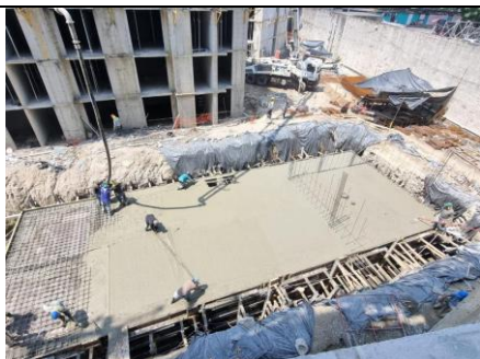
Fotografía 7. Colado de losa superior de cisterna de agua potable y contra incendio.
