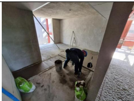
Fotografía 7. Nivelación de pisos en apartamentos del nivel 2, Torre C.
