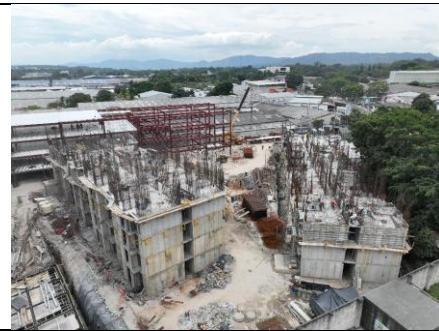
Fotografía 2. Armado de acero de paredes y losas en Torres A y B.
