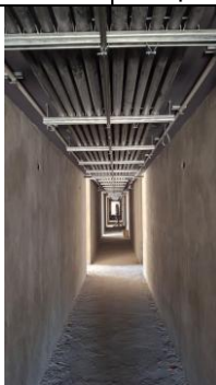
Fotografía 9. Instalación de canalización de sistemas en pasillo de Nivel 2 Torre C.
