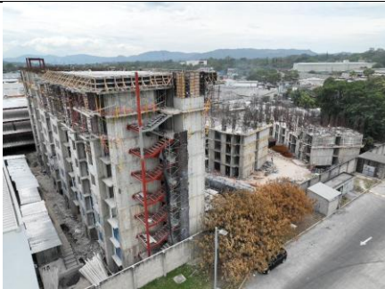
Fotografía 5. Vista de esquina nor poniente de Torre C.
