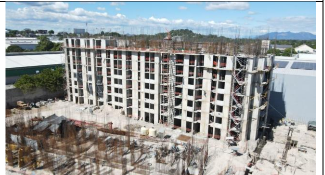
Fotografía 4. Vista de avance de Torre C.
