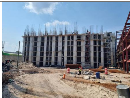
Fotografía 10. Limpieza de área entre Torre A y B.
