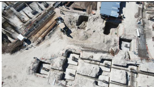
Fotografía 8. Excavación de zapatas en sector de rampa de edificio de estacionamientos.
