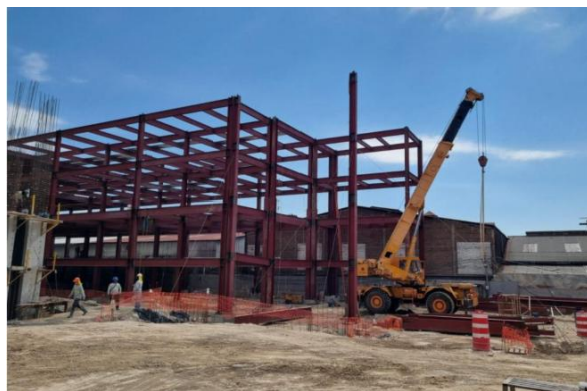
Fotografía 6. Avance en actividades de montaje de estructura metálica en edificio de parqueos..
