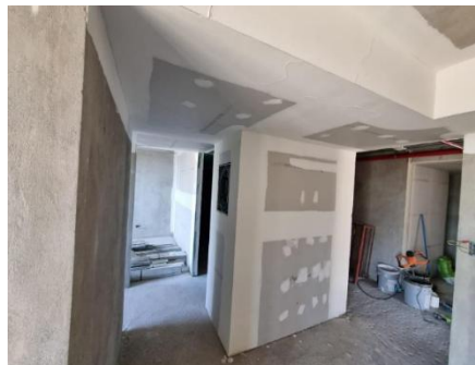
Fotografía 8. Divisiones livianas y cielo falso en aptos, Nivel 2 Torre C.
