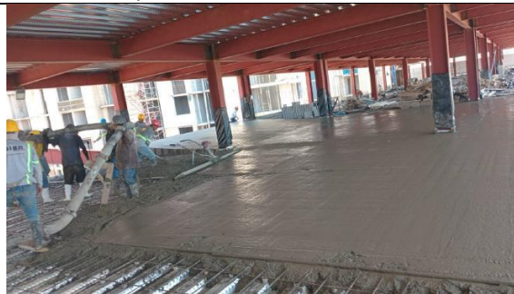
Fotografía 10. Colado de losas de entrepiso en edificio de Parqueos.
