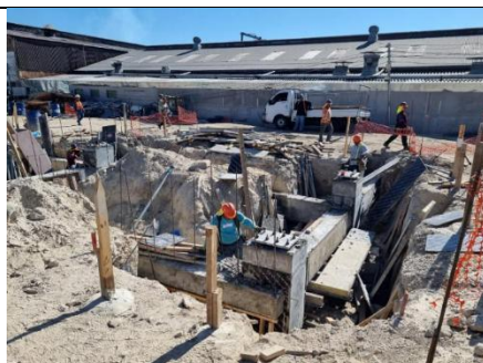
Fotografía 10. Finalización de construcción de fundaciones en eje 14 del edificio de Parqueos.
