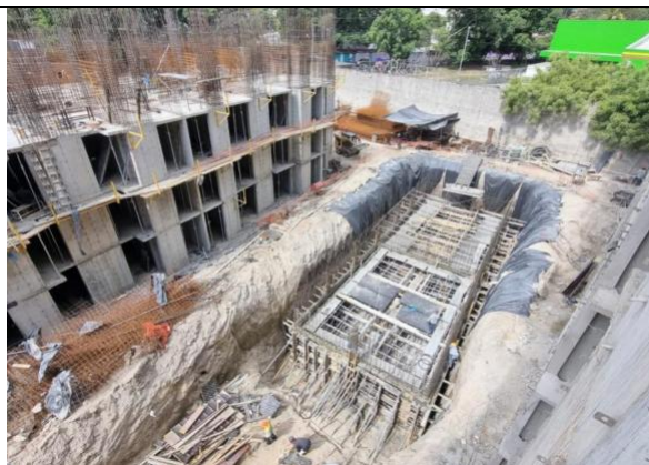
Fotografía 5. Avance de construcción de cisterna de agua potable y contra incendio..
