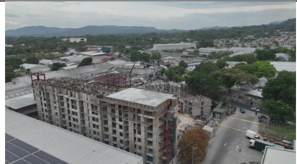
Fotografía 6. Primer tramo de losa de azotea colada en Torre C.
