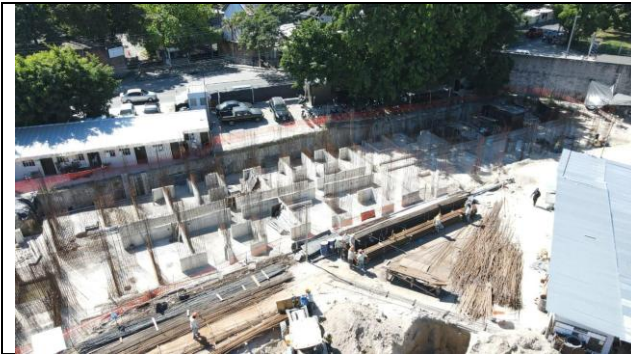
Fotografía 1. Colado de paredes h=1.20 m en fases 4 y 5 de Torre A.
