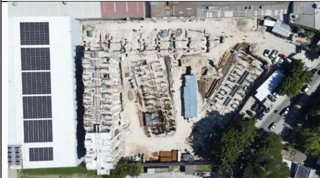
Fotografía 3. Vista general de avance de las torres A, B y C de apartamentos.
