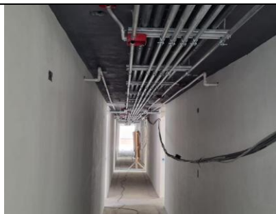
Fotografía 8. Instalación de canalizaciones de sistemas en pasillos de Torre B.
