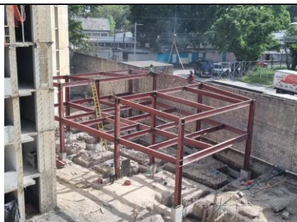
Fotografía 7. Estructura metálica para edificio de Amenidades.
